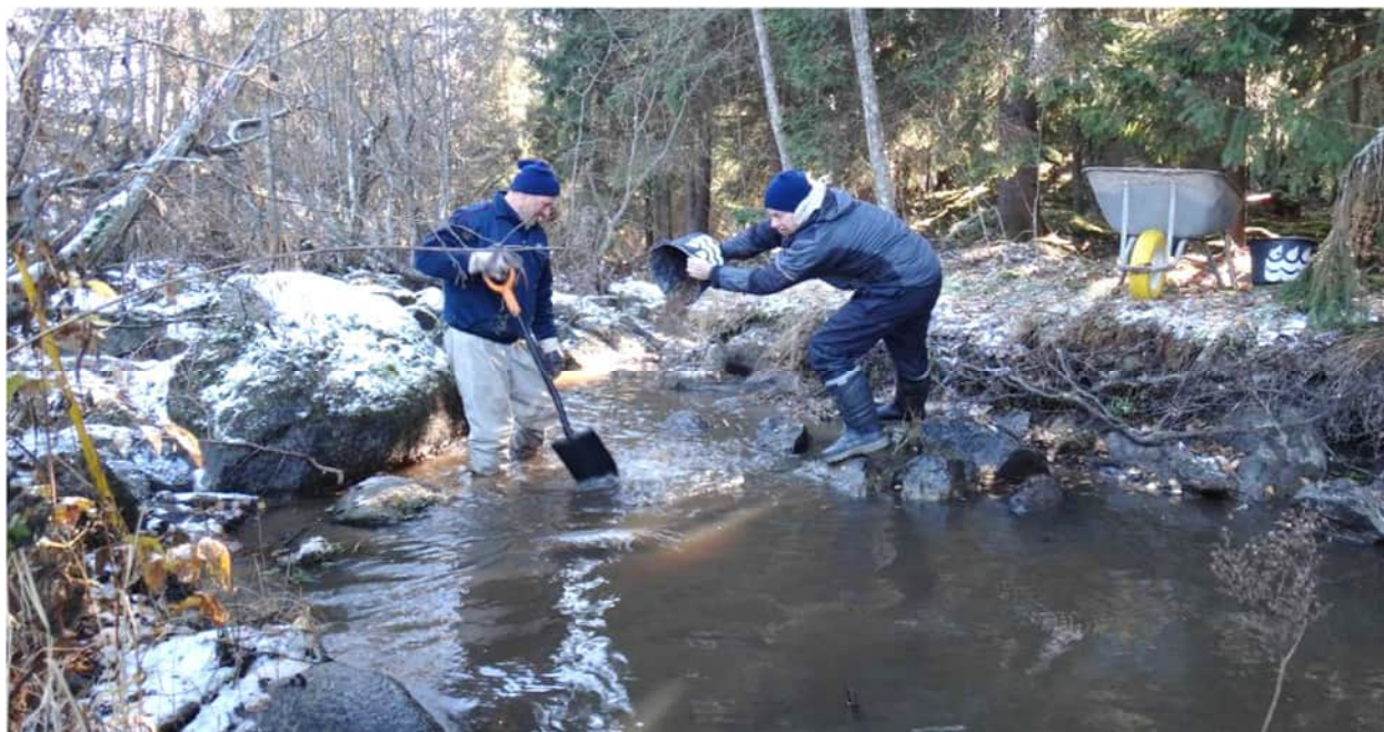
Kuva 2.10. Pirkanmaan ensimmäisissä virtavesitalkoissa Rautajoen uoman Koskelon ja Yrjölän koskialueille tehtiin taimenten lisääntymiseen soveltuvia kutusoraikkoja ja kivettiin uomaa poikasalueiksi (kuva: Heikki Holsti, KVVY Yhdistys).
