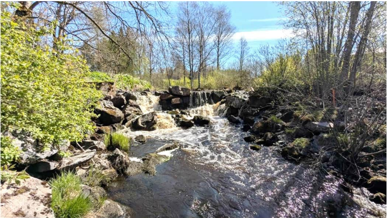
Kuva 2.28. Taipaleenjoen Prusinkosken niskalla oleva kivipato estää kalojen nousun uomassa (kuva: Heikki Holsti, KVVY Yhdistys).
