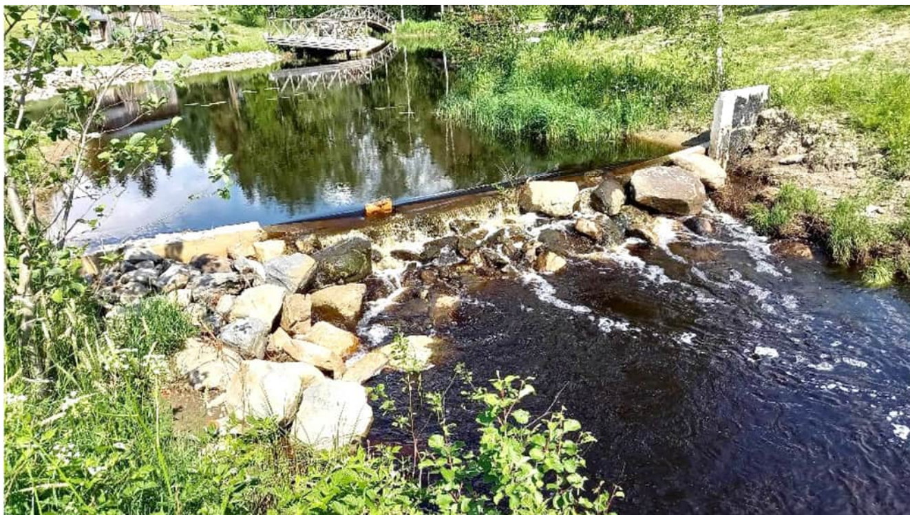
Kuva 2.7. Uudehkon näköinen patorakenne Vaunujoessa vuonna 2021 (kuva: Heikki Holsti, KVVY Yhdistys).
