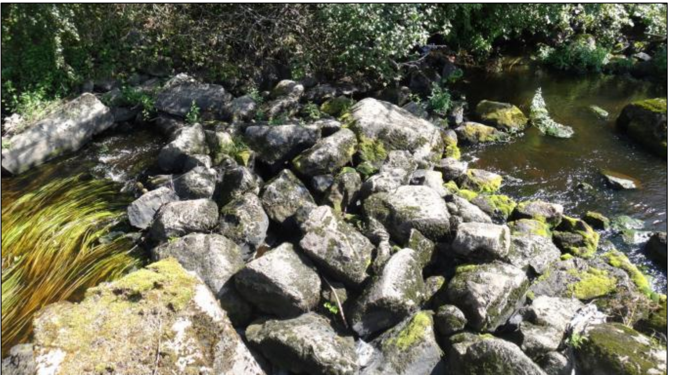
Karttapiste K15. Kukkarokoskessa vanhan myllyn kohdassa oleva kivistä tehty pato. Vesivirtaa kivien raoista, muodostaen kaloille ylitsepääsemättömän nousuesteen.
