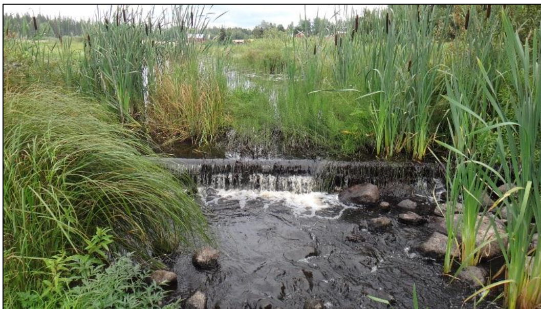
Kuva 4.1. Sävijoen luusuassa oleva pohjapato.
