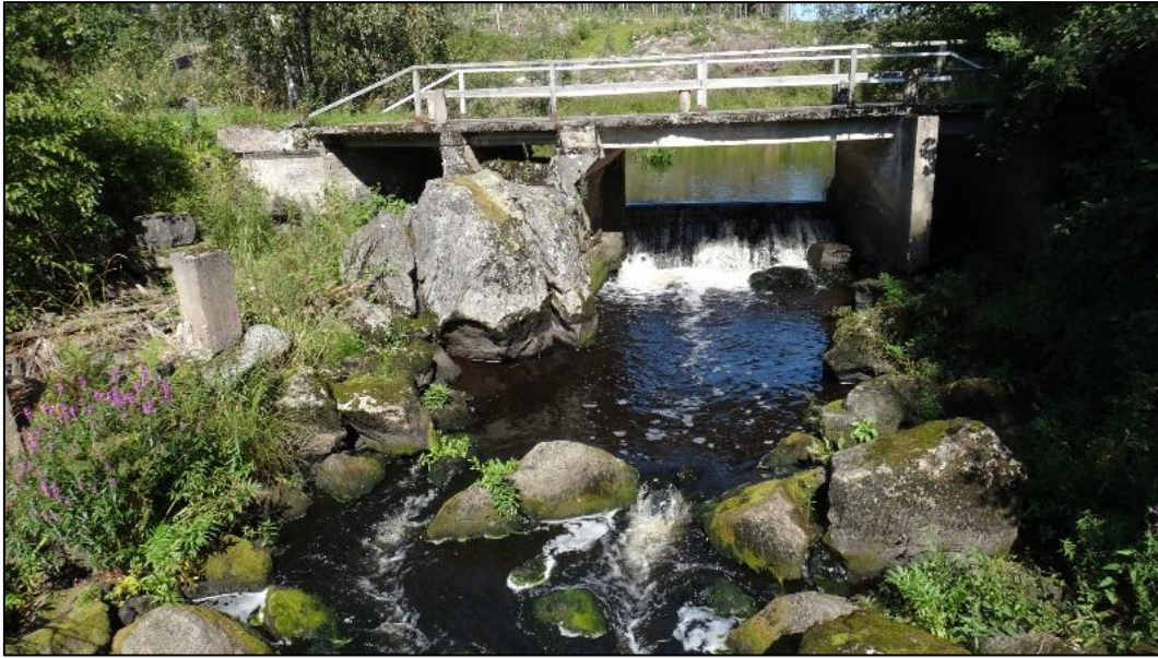
Kuva 5.5. Jyränkosken pato. Pato toimii kalojen totaalisena nousuesteenä.
