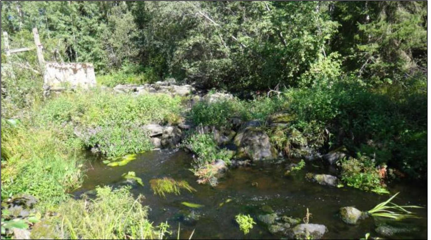
Karttapiste K15. Kukkarokosken pato alavirrasta päin kuvattuna. Kivisen padon vasemmalla puolella on betonista rakennettua vanhaa patorakennelmaa. Padon alapuolella on koskialuetta, joka sopisi taimenen elinalueeksi.
