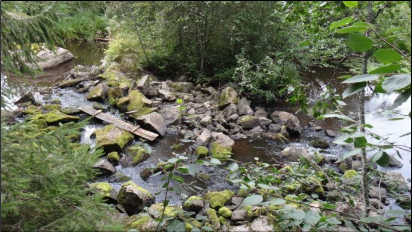
Karttapiste S22. Lampareen laskukohdassa on kivistä tehty pato. Padolla on oletettavasti yritetty nostaa lampareen vesisyvyyttä ja parantaa sen virkistyskäyttöä. Kivipato estää kalojen vapaan liikkumisen.
