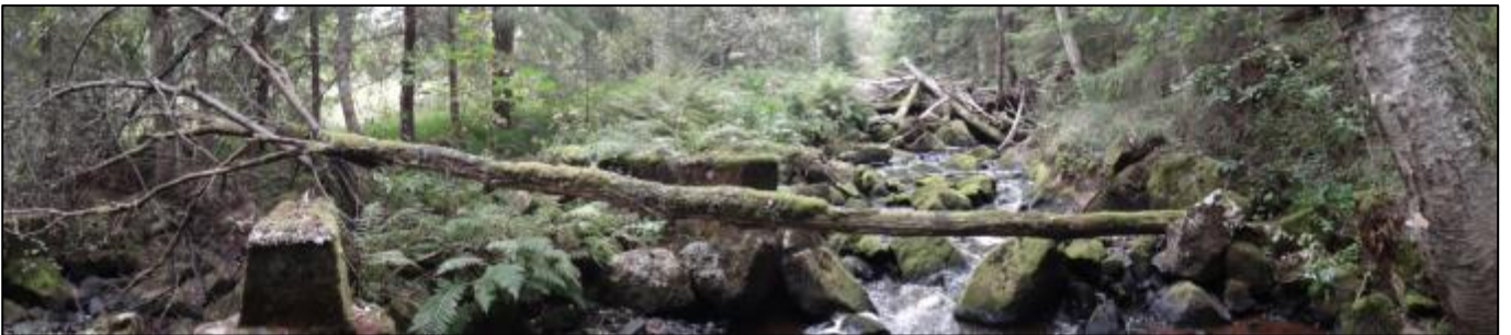
Karttapiste S15. Kotakosken padosta toinen kuva alempaa. Kotakoskessa on nähtävissä vanhan myllyn/sahan betoniset tukirakenteet.
