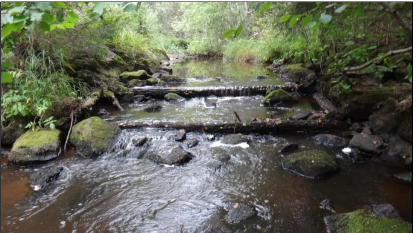
Karttapiste S14. Kotakosken niskalla olevia tukeista tehtyjä pohjapatoja.
