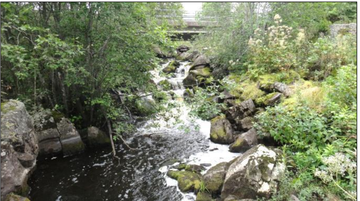
Karttapiste T9. Nousuesteen alapuolella on kiivasvirtainen, mutta lyhyt koski. Kuva otettu ylävirran suuntaan. Kuvassa näkyy siltä, josta nousuestettä on kuvattu.
