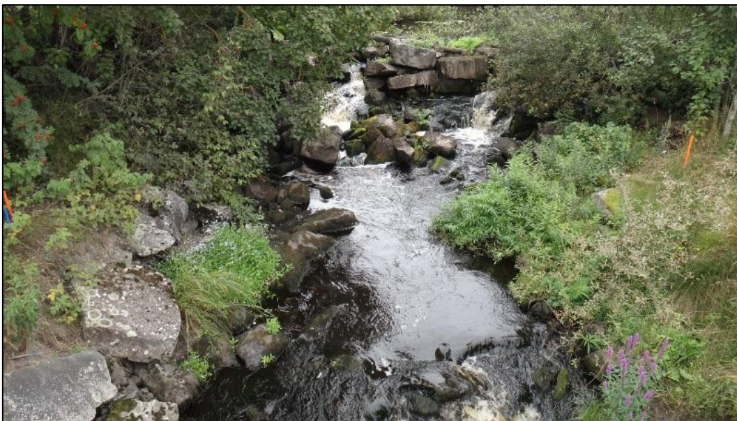
Kuva 4.5. Taipaleenjoen ylittävän alemman maantiesillan kohdalla oleva patorakennelma.
